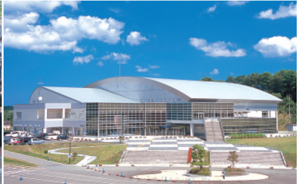
屋内外の施設が充実し、スポーツ合宿の利用も多いスポーツ交流村・ベイスайдアリーナ
