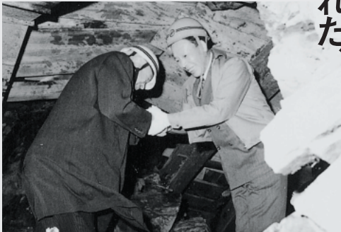
新水界トンネル貫通直後、志津川・東和の両町長が握手
