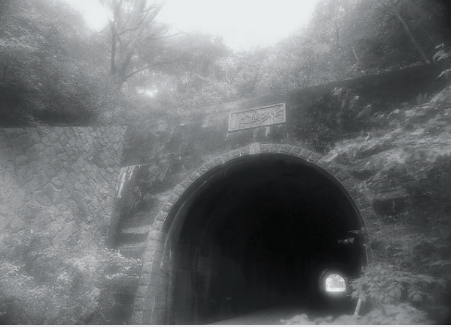
県内で初めてのトンネル（明治19年竣工）水界トンネル
