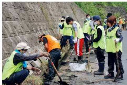
側溝の泥カキ作業(平成24年8月3日)
