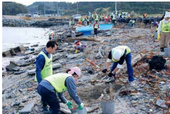
海岸でのガレキやゴミの撤去作業(平成24年10月21日)
