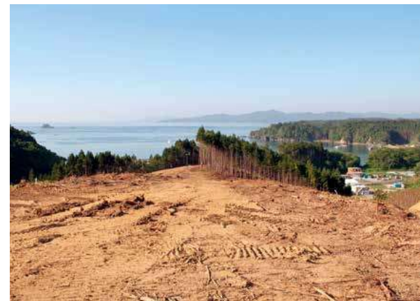
造成中のみねはた団地
