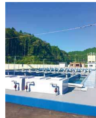
再建したシロザケふ化場（水尻）
