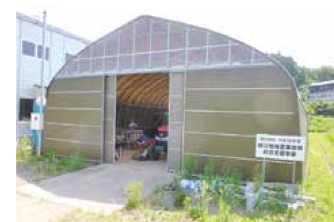
平成26年度被災地域農業復興総合支援事業で整備した園芸ハウス
