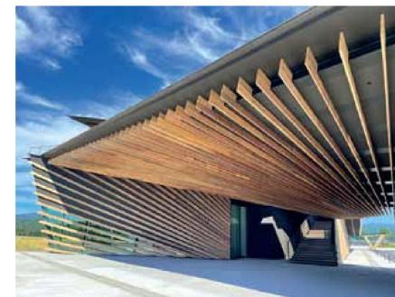
南三陸杉を活用した震災伝承施設「南三陸 311 メモリアル」
