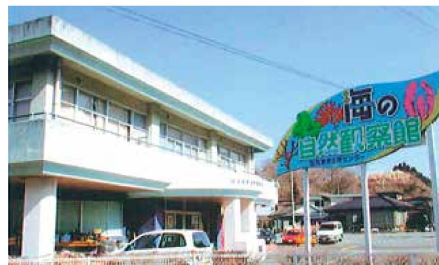
震災前の南三陸町自然環境活用センター
