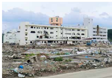
被災した公立志津川病院
