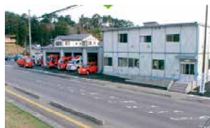
南三陸消防署仮設庁舎(平成25年4月)
