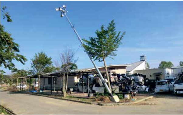
被災した指定避難所（ボランティアセンター）
