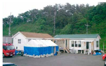
南三陸消防署仮庁舎(平成23年4月)
