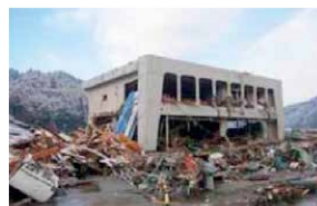
全壊した南三陸消防署
