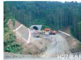
熊田地区（志津川IC付近）の工事（平成27年8月）
