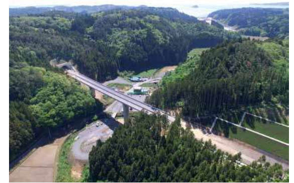
「南三陸道路」の建設（平成29年5月）
