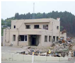
損壊した上下水道事業所
