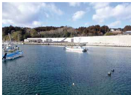
高潮対策事業で新規整備した堤防(稲淵漁港)
