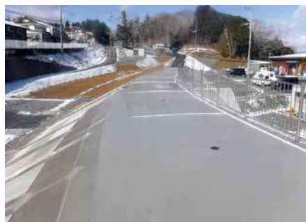
高潮対策事業によって被災した防潮堤に隣接して新規に整備した堤防(津ノ宮漁港)
