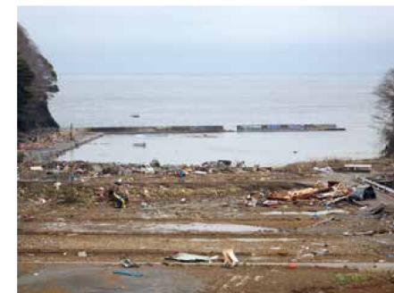
岸壁及び防波堤の被害(藤浜漁港)
