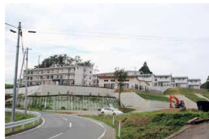
災害公営名足住宅
