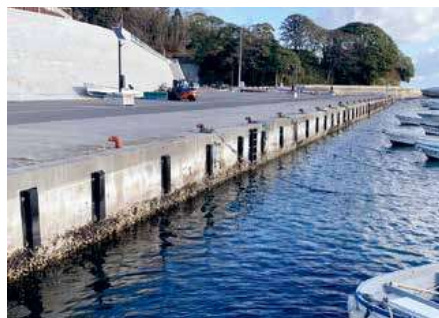
災害復旧事業で整備した物揚場及び防舷材(荒砥漁港)
