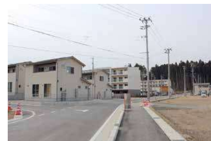
志津川地区 災害公営志津川中央住宅
