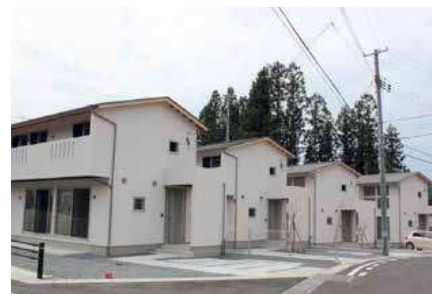
入谷地区 災害公営入谷住宅
