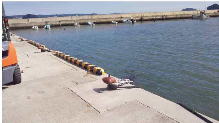
復旧した岸壁(折立漁港)
