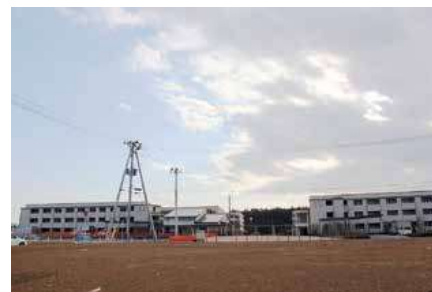
志津川地区 災害公営志津川東住宅
