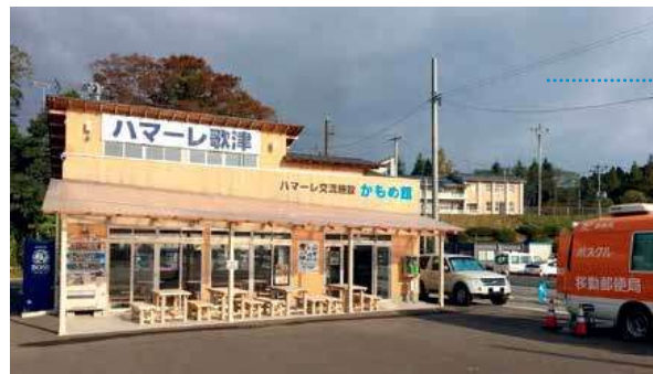
ハマーレ歌津交流施設「かもめ館」
