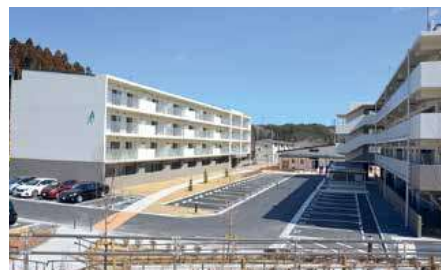
竣工した志津川中央復興住宅第1・2街区
