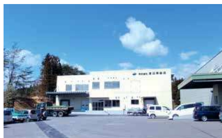
水産ゾーン：施設整備
