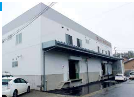
水産ゾーン：施設整備
