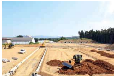
志津川西団地東工区 平成28年11月2日現在
