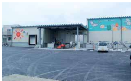
水産ゾーン：施設整備
