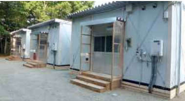
完成した応急仮設住宅（外観）
