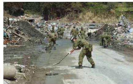
道路の啓開作業
