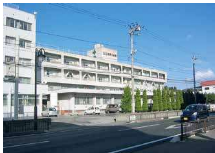
震災前の公立志津川病院（平成19年撮影）
