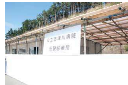
4月13日に開設された公立志津川病院仮設診療所
