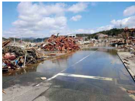
南町山内鮮魚店前、冠水した道路(南町)
