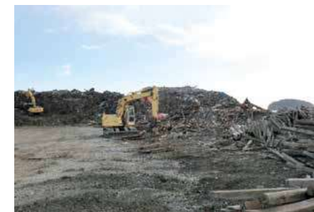
くろしおグラウンド一次仮置き場
