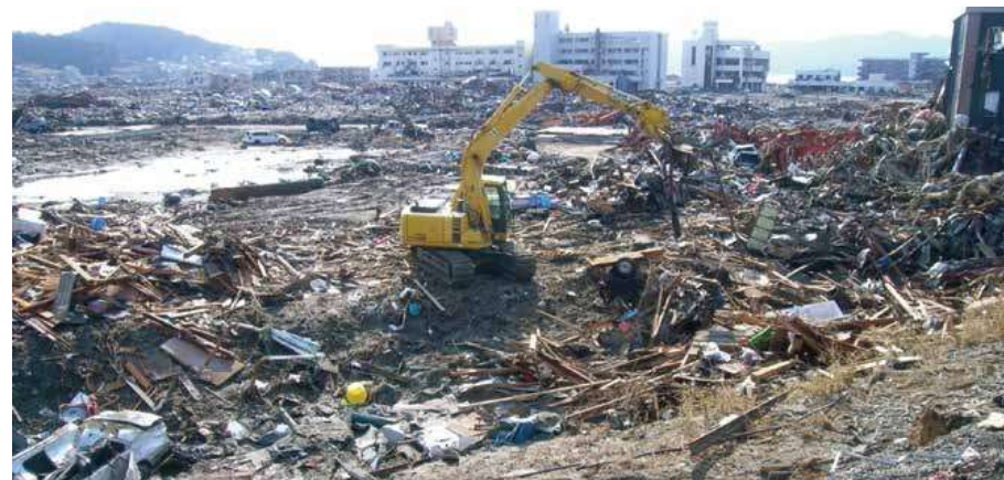
道路の啓開作業
