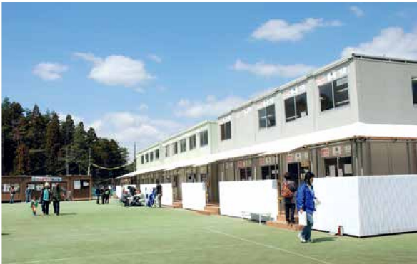
プレハブ仮設庁舎
