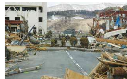
道路の啓開作業
