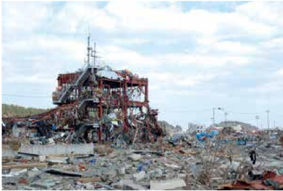
被災した防災対策庁舎
