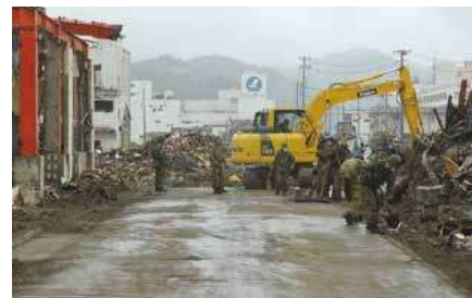
道路の啓開作業
