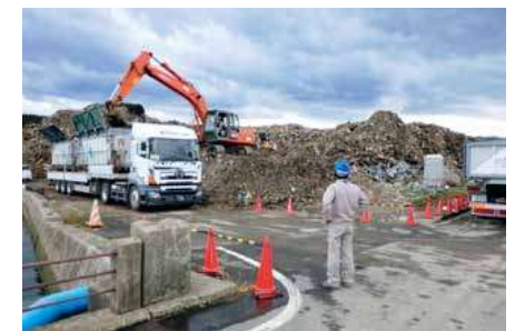
くろしおグラウンド一次仮置き場
