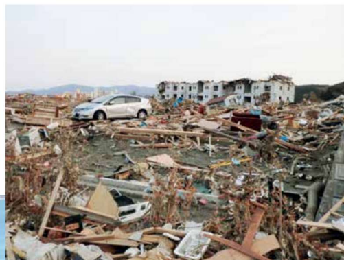
廻館前(県営住宅付近)
