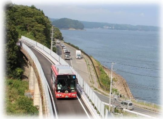
JR 気仙沼線（BRT 専用軌道部分）
