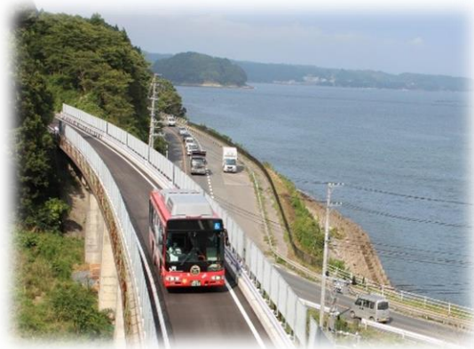
JR 気仙沼線（BRT 専用軌道部分）
