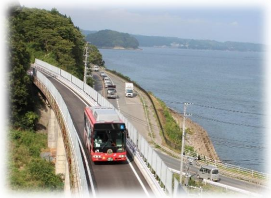
JR 気仙沼線（BRT 専用軌道部分）
