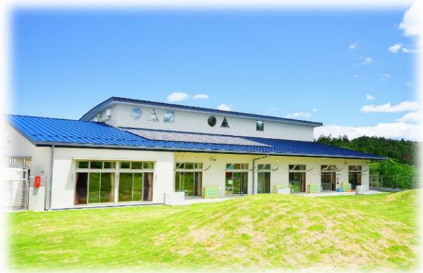
〔歌津地区子育て拠点施設〕
