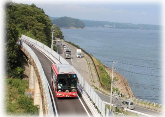
JR 気仙沼線（BRT専用軌道部分）
