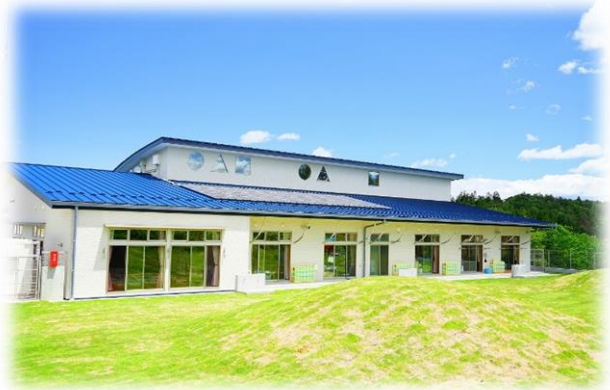
〔歌津地区子育て拠点施設〕
