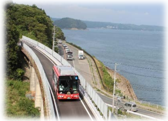
JR 気仙沼線（BRT 専用軌道部分）
