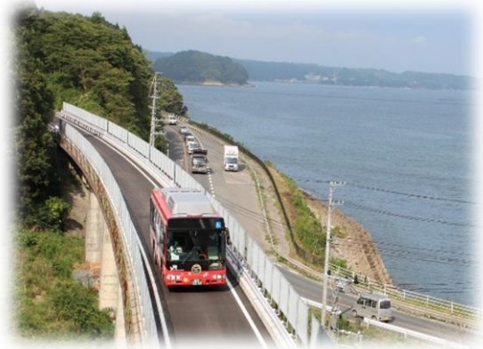
JR 気仙沼線（BRT 専用軌道部分）
