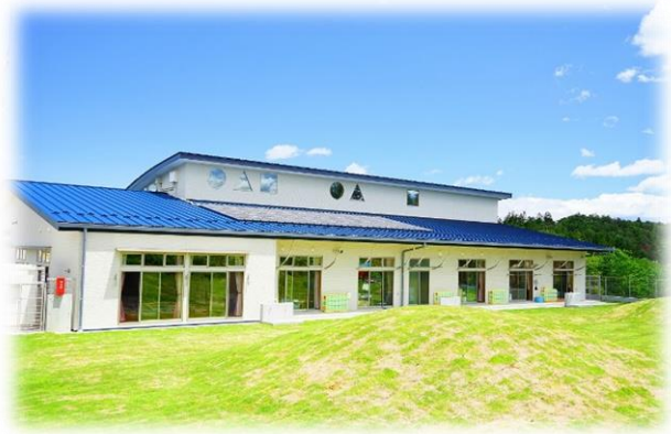
〔歌津地区子育て拠点施設〕
