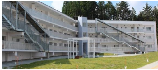
災害公営名足住宅（町営名足復興住宅）
