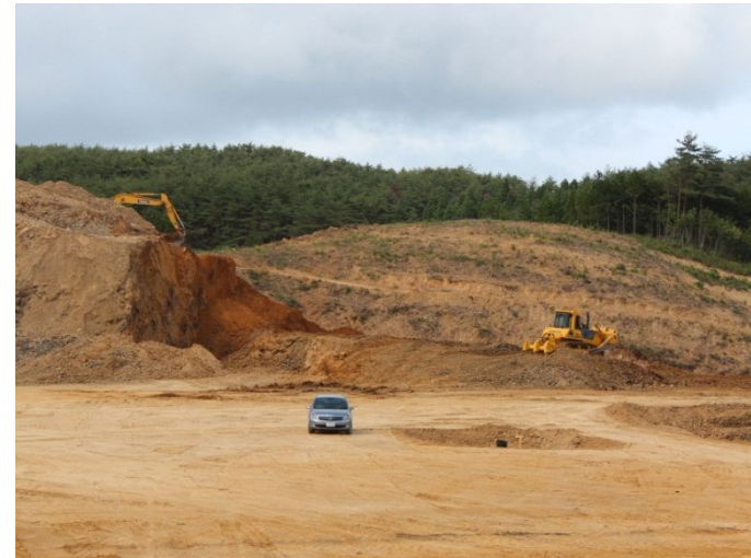
造成が進む『伊里前地区中学校上団地』
