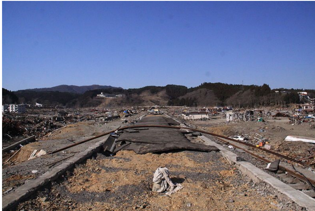
志津川駅のプラットフォーム ホーム上を横切るのは津波に 捻じ曲げられたレール。
