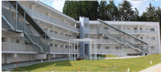
町営入谷復興住宅
