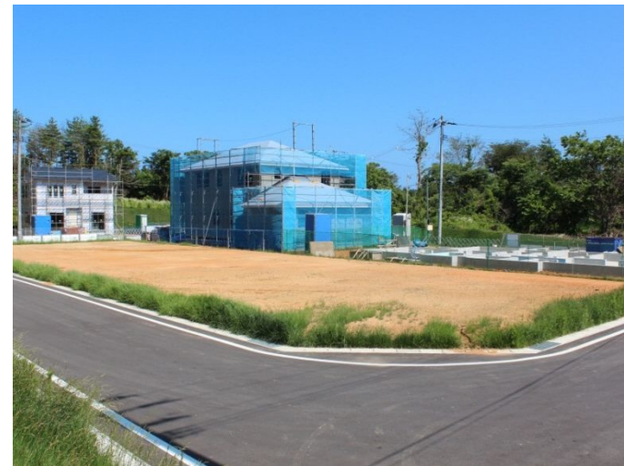
住宅建設が進む『藤浜団地』
