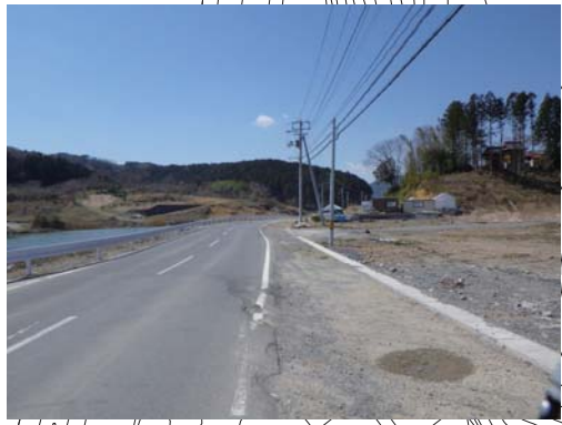
③国道398号(南側)から対象地を望む
