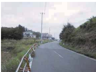
⑦ 西側県道から北西を望む
