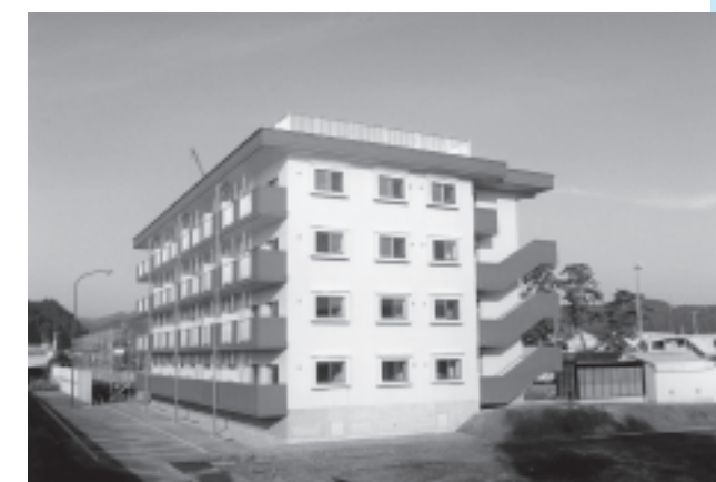
▲松原住宅建設事業
