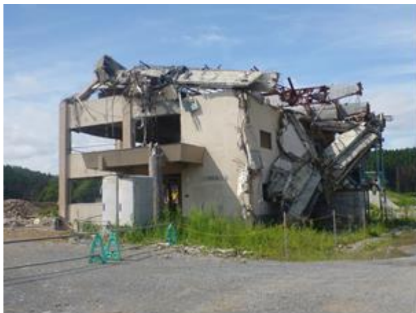
志津川公民館（平成 24 年 8 月 15 日撮影）
