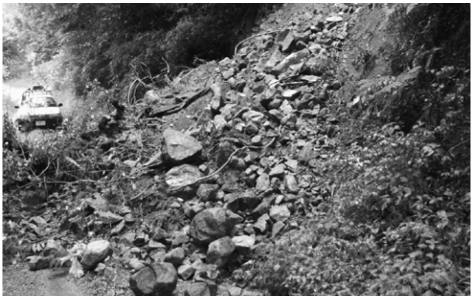
▲ 土砂崩れ対策は
