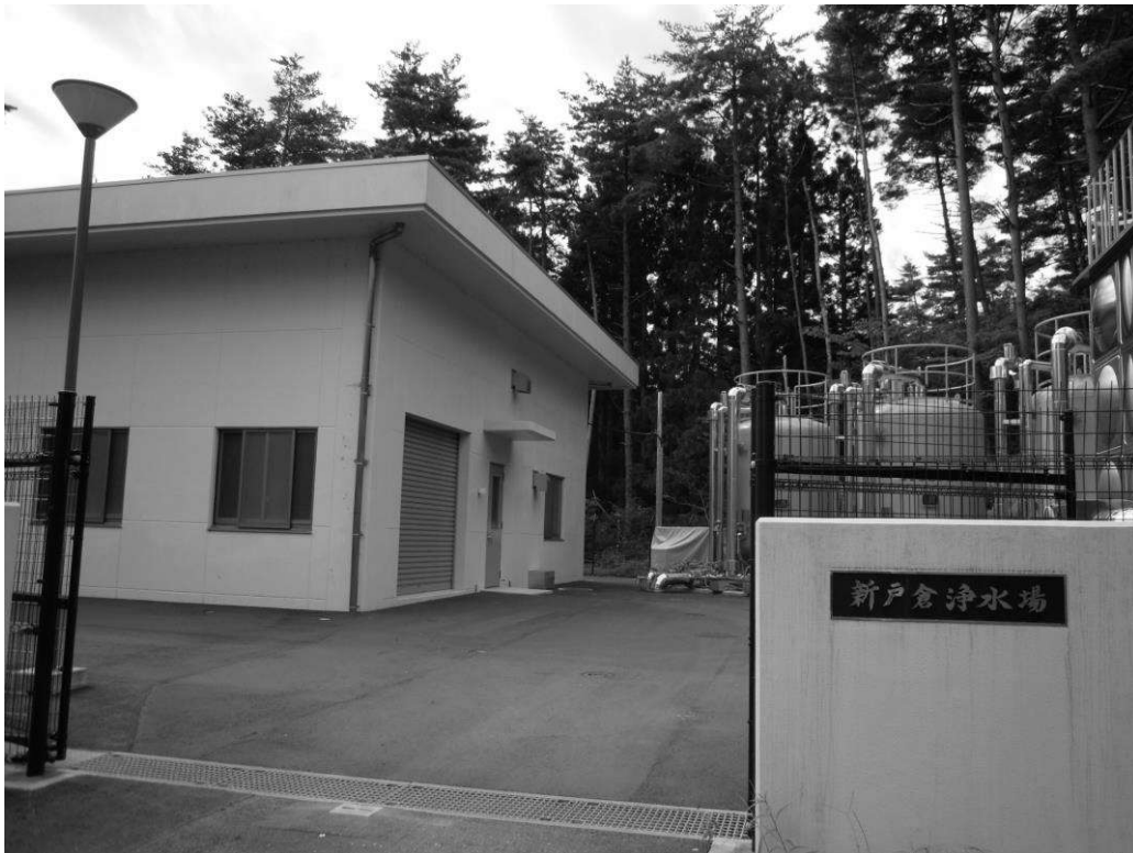
図. 新戸倉浄水場
