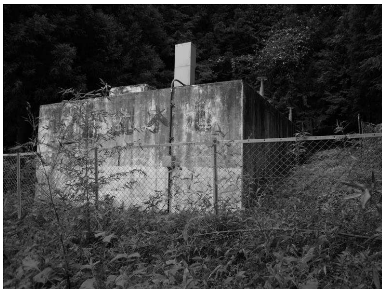
図. 大羅配水池
