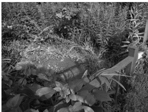
図. 権現配水池
