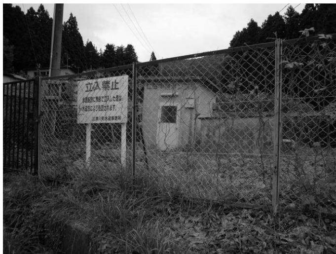
図. 仁田中継ポンプ場
