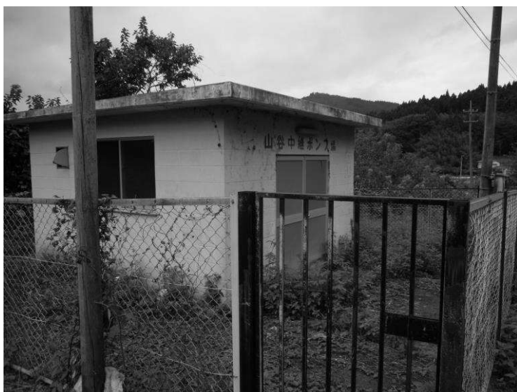
図．山谷中継ポンプ場
