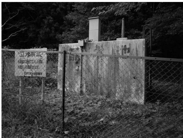
図．山谷配水池
