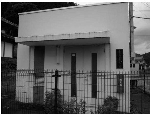
図. 小森中継ポンプ場
