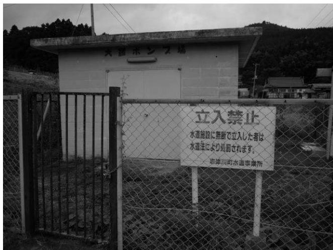
図. 大羅中継ポンプ場
