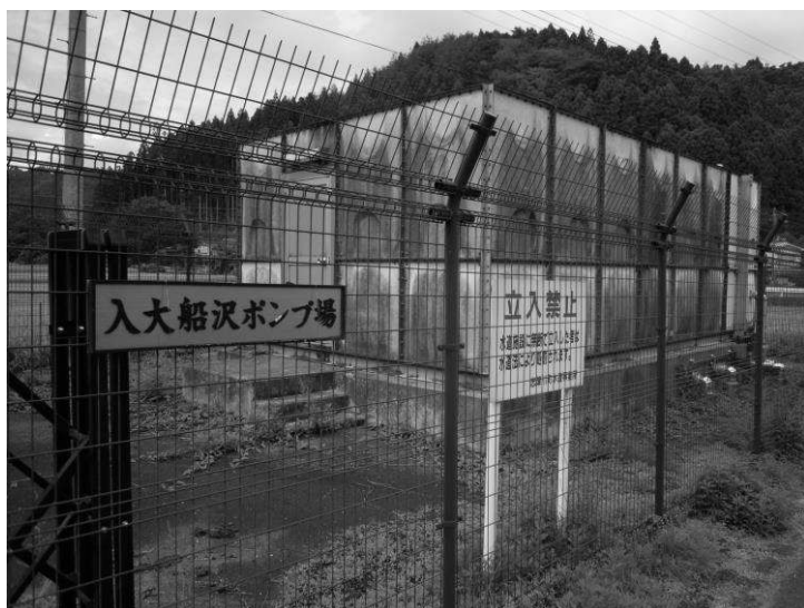
図. 入大船沢加圧ポンプ場
