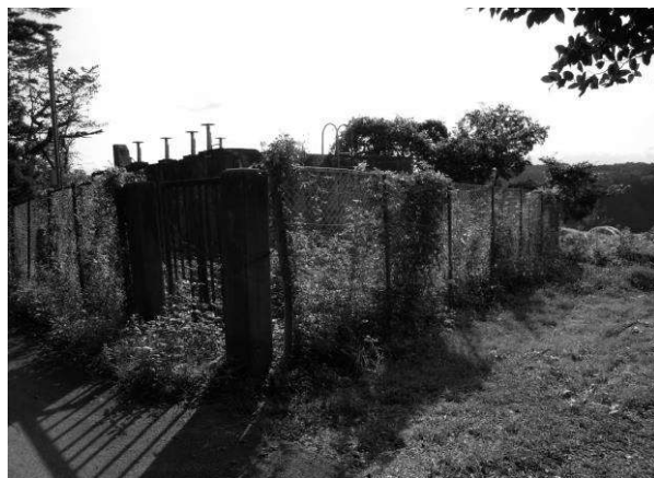
図. 森山配水池
