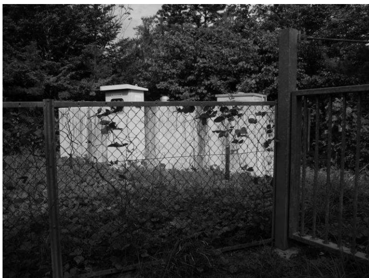
図. 樋の口配水池
