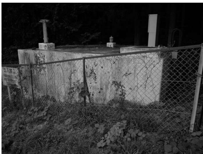
図. 残谷配水池
