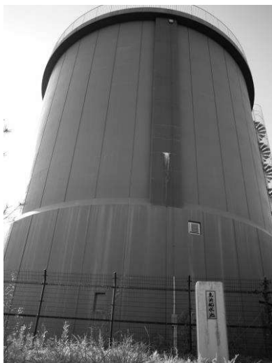
図. 東浜配水池
