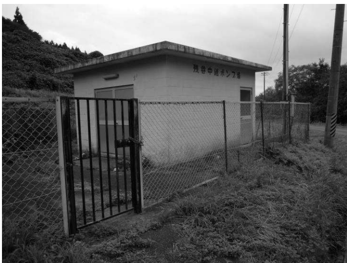
図. 残谷中継ポンプ場
