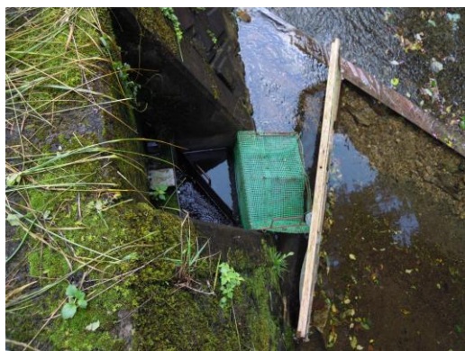
図. 原水取水口
