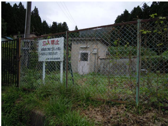
図. 仁田中継ポンプ場
