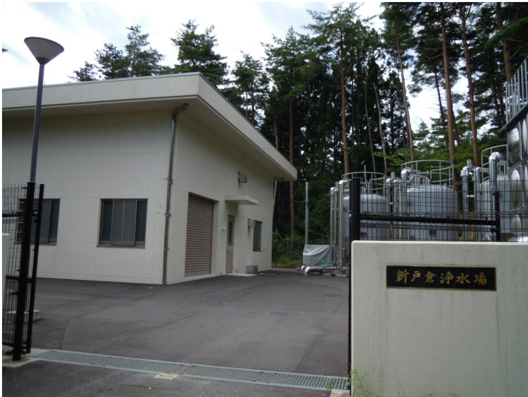
図. 新戸倉浄水場
