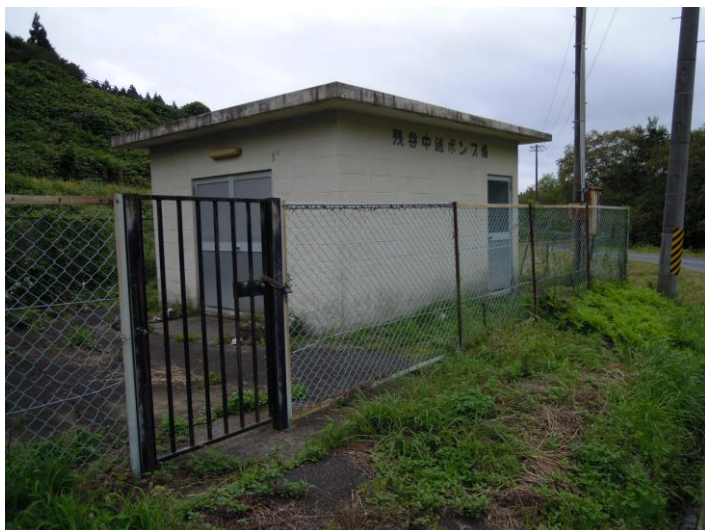
図. 残谷中継ポンプ場
