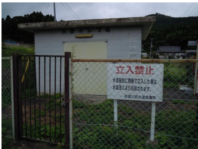
図. 大羅中継ポンプ場
