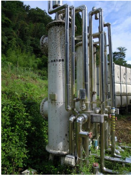
図. 急速ろ過機
