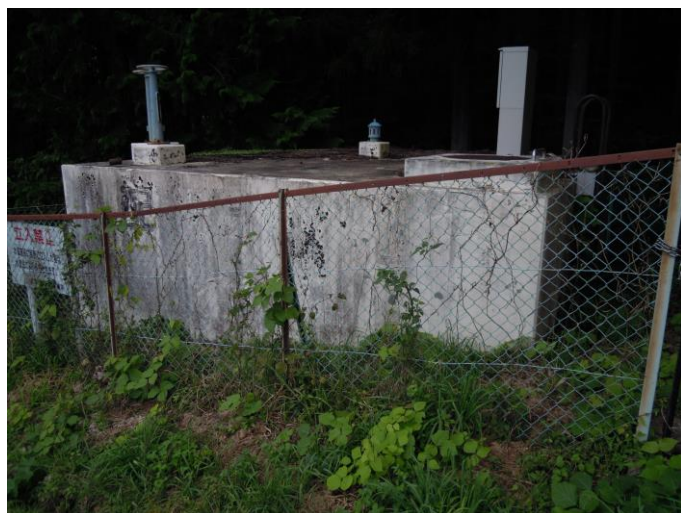
図. 残谷配水池
