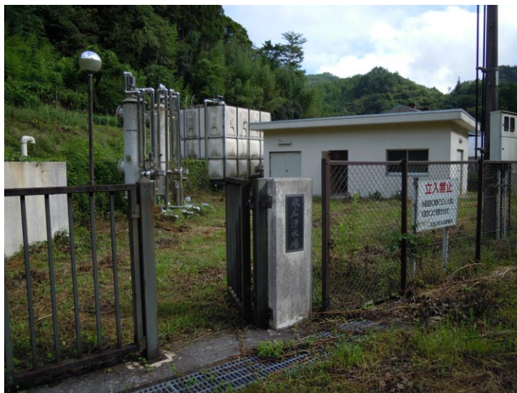
図. 米広浄水場
