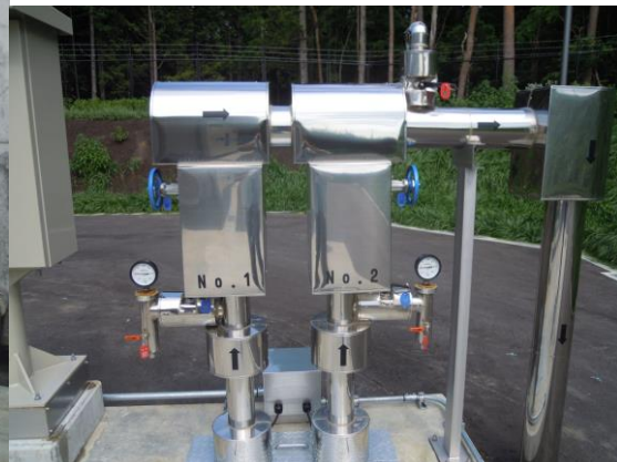
図. 排水ポンプ設備
