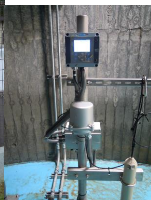
図. 取水井内 原水濁度計
