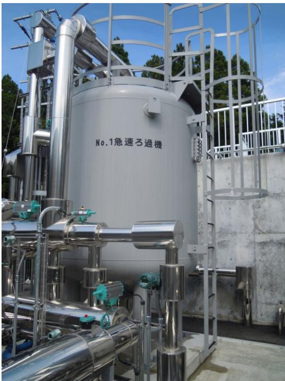
図. 急速ろ過機
