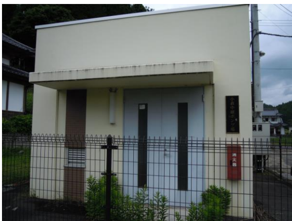
図. 小森中継ポンプ場
