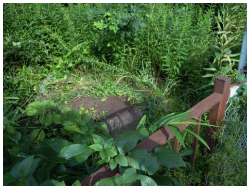
図. 権現配水池
