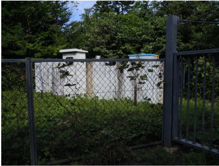
図. 樋の口配水池
