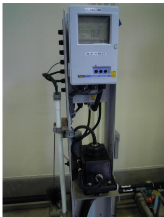
図. 原水濁度計
