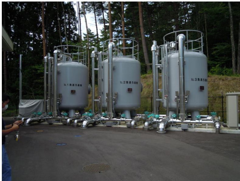
図. 急速ろ過設備
