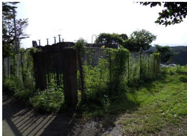
図. 森山配水池
