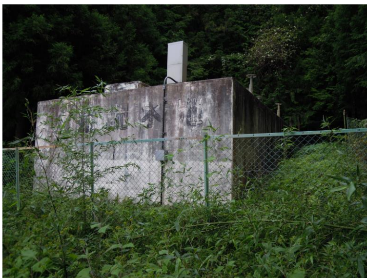
図. 大羅配水池
