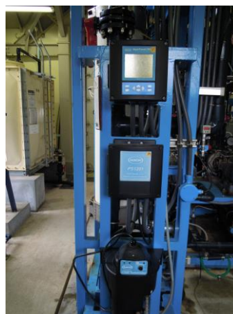
図. ろ過出口濁度計
