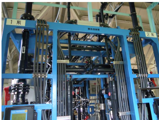
図. 膜処理装置 1系 2系
