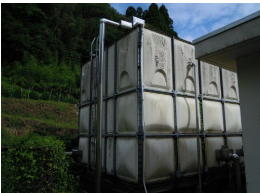
図. FRP製浄水池兼配水池
