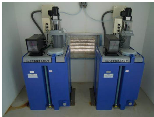
図. 塩素注入装置 1号2号
