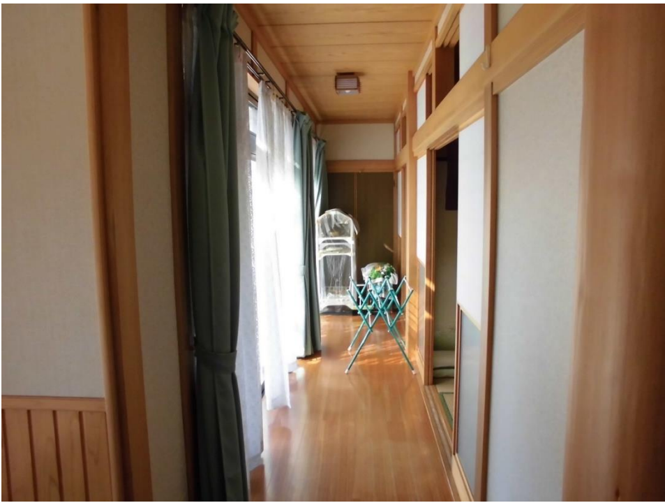
1階 和室前 廊下
