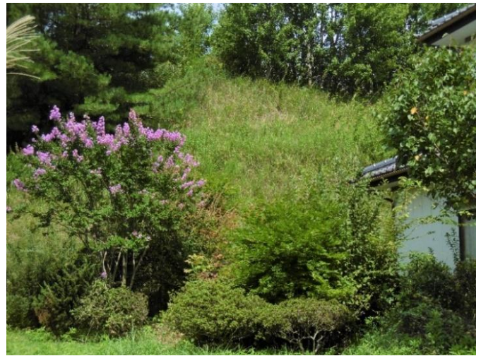
建物裏の法面
