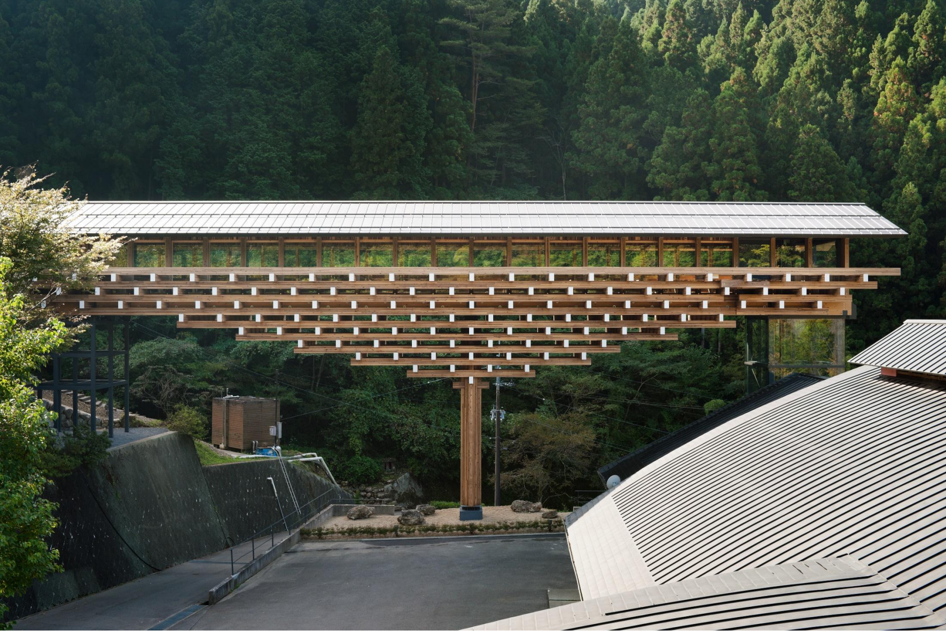
木橋のイメージ 栲原木橋ミュージアム 15 (隈研吾建築都市設計事務所)
