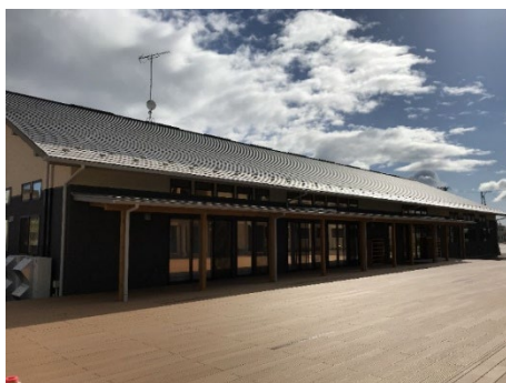
建物全景（南側）
