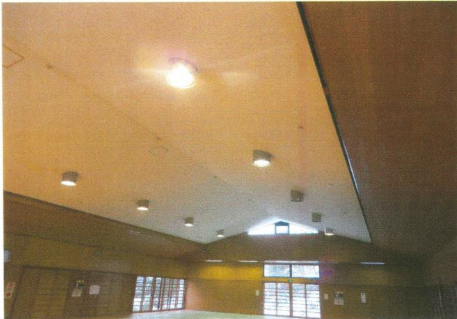
柔剣道場 振止・内装工事
