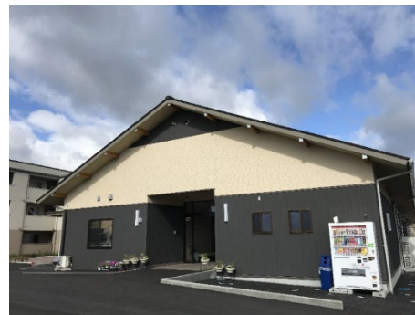
建物全景（東側）
