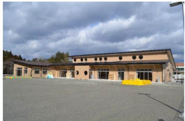
②保育所側からの外観
