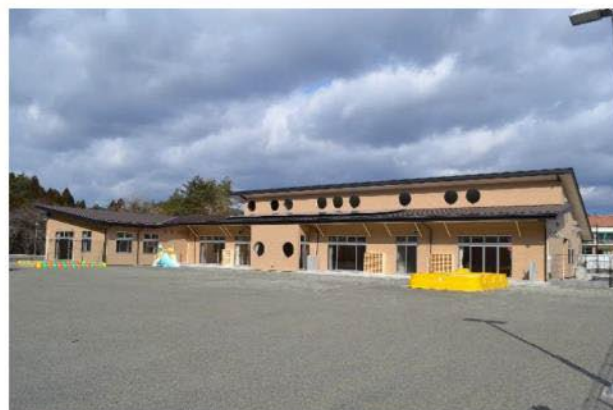
②保育所側からの外観
