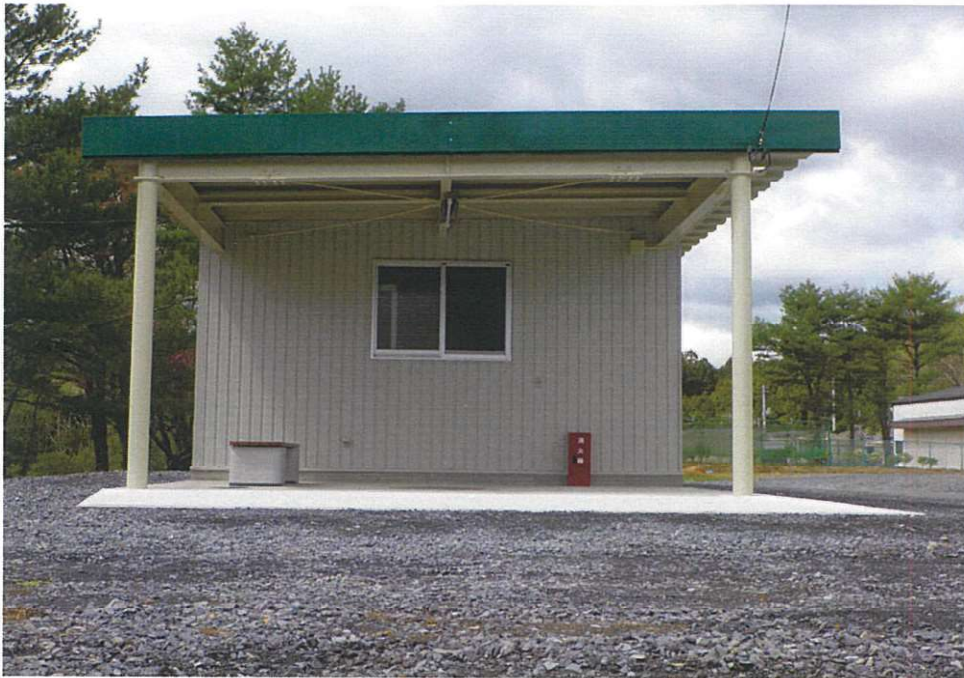
建物外部東面
