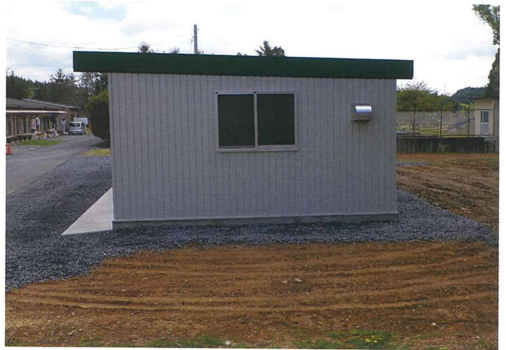
建物外部西面
