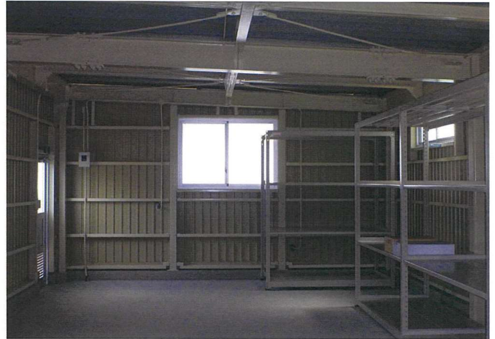
建物内部西面
