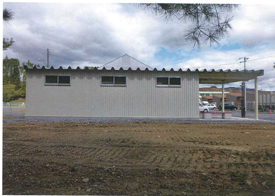
建物外部南面
