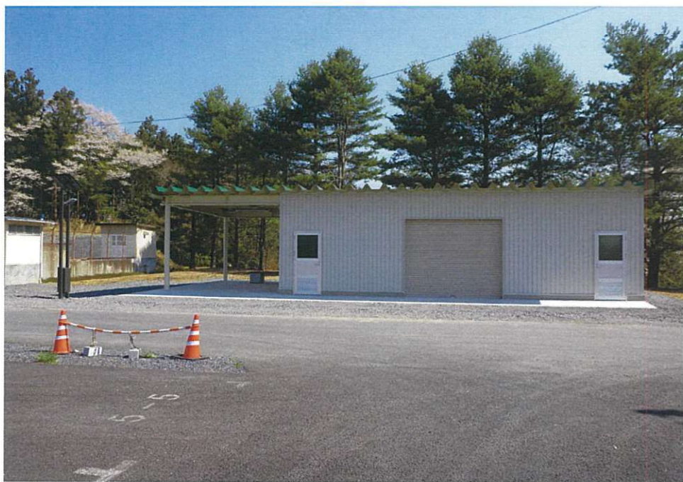
建物外部北面
