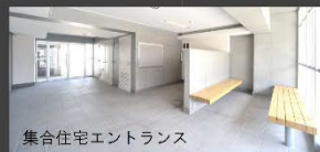
集合住宅エントランス
