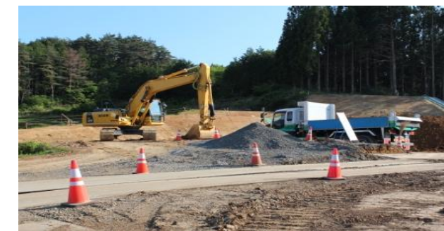
入谷桜沢災害公営住宅造成工事の様子
