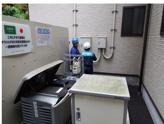
ガスバルク発電設備を稼働させる様子
