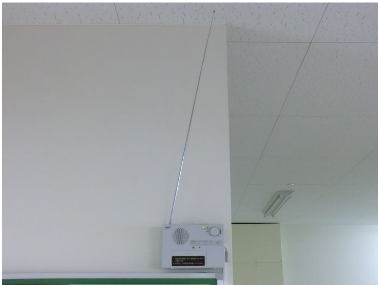
戸別受信機（屋外設置のダイポールアンテナと接続の例）
