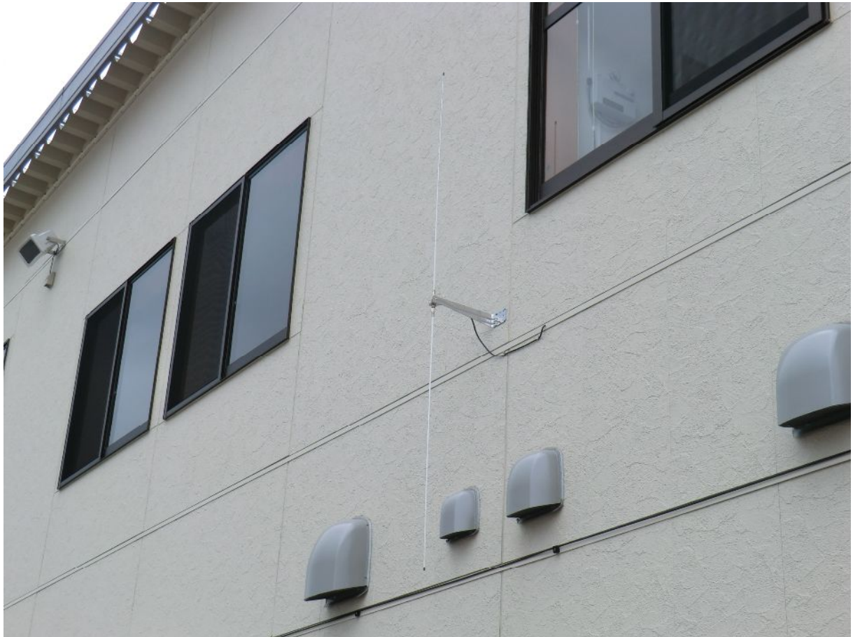
ダイポールアンテナ設置の例（役場庁舎壁面）
