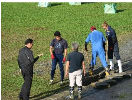
側溝のふた戻し
