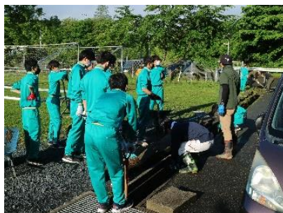
側溝の泥上げ
