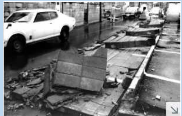
宮城県沖地震で倒壊したブロック塀。塀や門柱の下敷きとなって18人が死亡した＝宮城県気仙沼市内で1978年6月12日撮影
