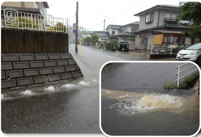
旭ヶ丘の道路は、道路脇の水路が大雨により一杯になり、水路の蓋から雨水が勢いよくあふれ出ており、一部が川のような様子でした。
