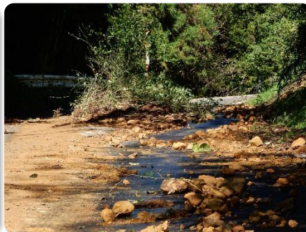
田尻畑から旭が丘に抜ける山道では、山が崩れ道をふさいでいました。
