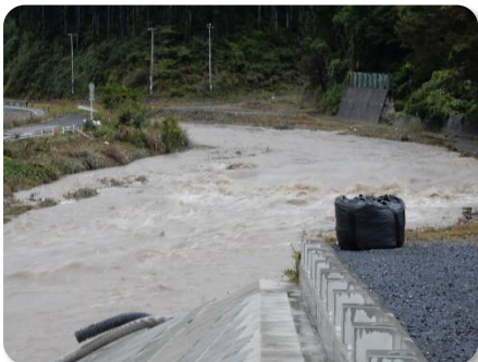
志中大橋の下は13日6時には水が引いていましたが水はここまでできていました。
