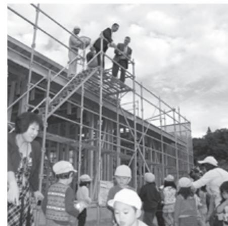
▲ 生涯学習センター上棟式
