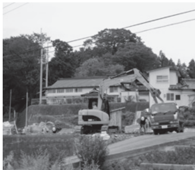
▲ 基礎撤去はじまる
