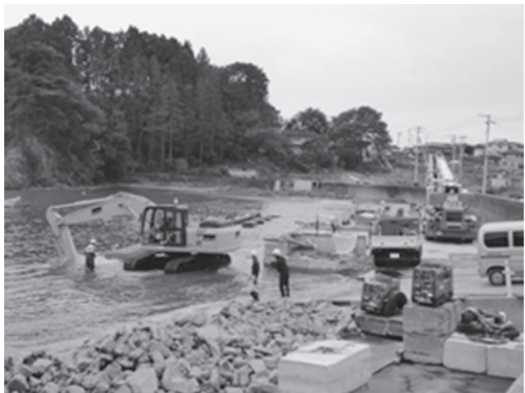
荒砥漁港災害復旧工事
