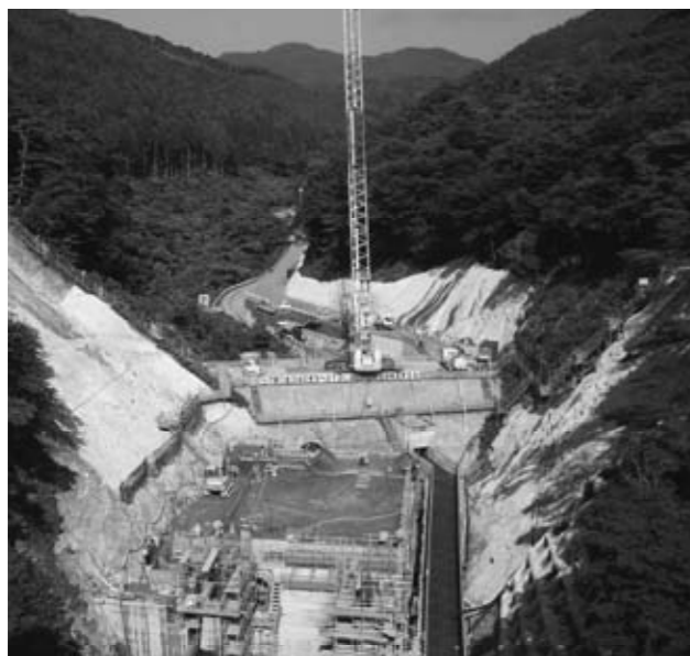
▲ 工事が進む弘川ダム
