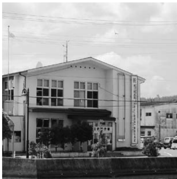
▲ 新庁舎の建設は
