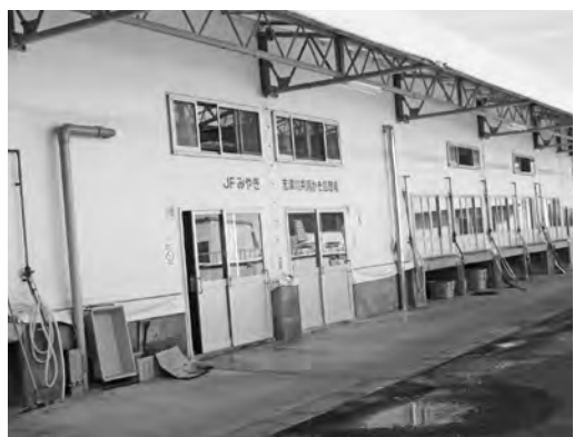
新設されたカキ処理施設
