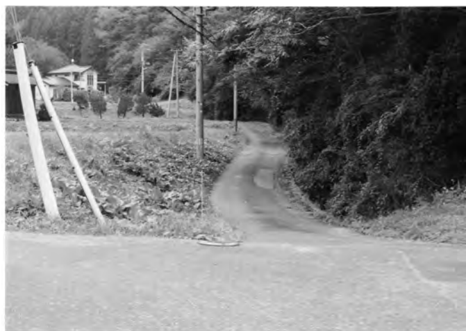
改良工事が待たれる小森熊田線
