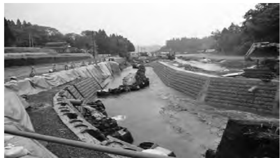
急ピッチで進む復旧工事
