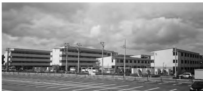
アリーナ向かいの志津川地区の災害公営住宅
