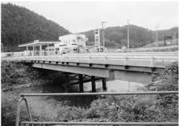
そのうち撤去される小森仮設橋
