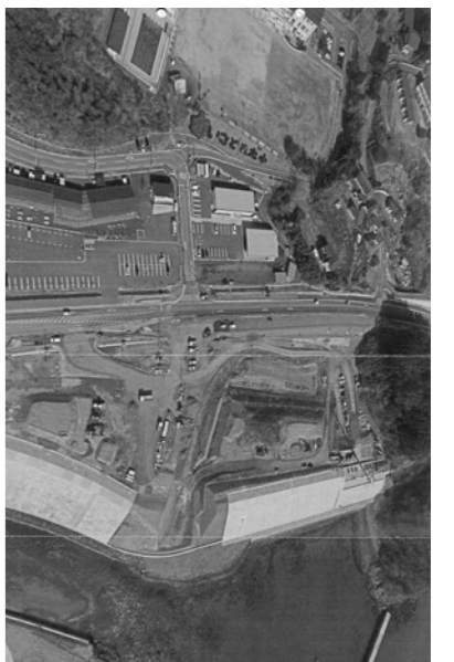
ハマール歌津南側整備中
