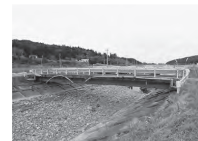
水戸辺川 最上橋
