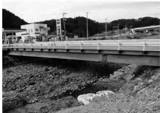
復旧工事完了後解体撤去される小森地内の牛峯橋
